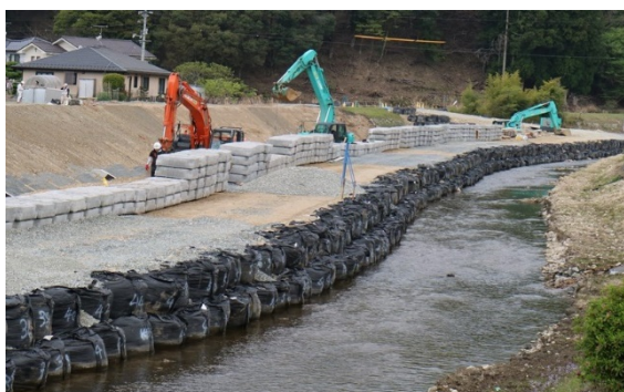
復旧工事が進む多治比川（吉田地区）
