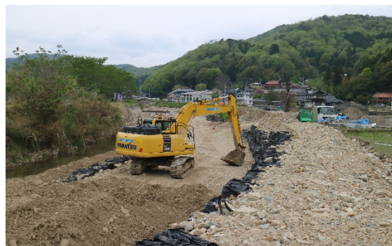
復旧工事が進む多治比川（丹比地区）
